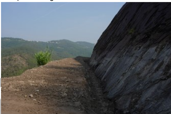
CAVA PONTENUOVO in Comune di Rocchetta Vara (SP) - acque di raccolta
