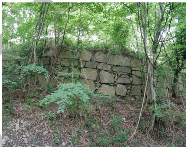
Figura 15 - muro di contenimento al piede della struttura di deposito
