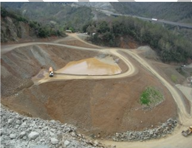
CAVA ACQUAFREDDA in Comune di Castiglione Chiavarese (GE) - primi mesi 2005
