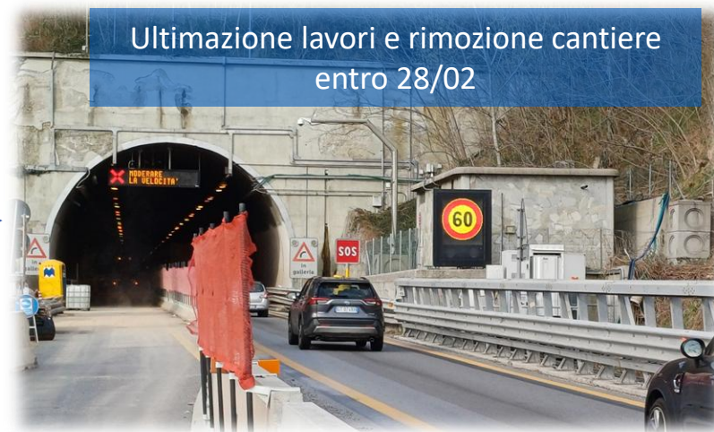
SUD km 118-122: 10 Viadotti «Lotto 4» dir. SV (Liguria, SV)
